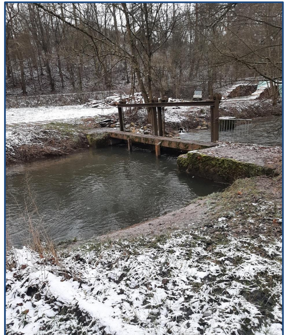
Wehr am Einlauf zum Mühlgraben, 01/2023 (Quelle: ThLG)
