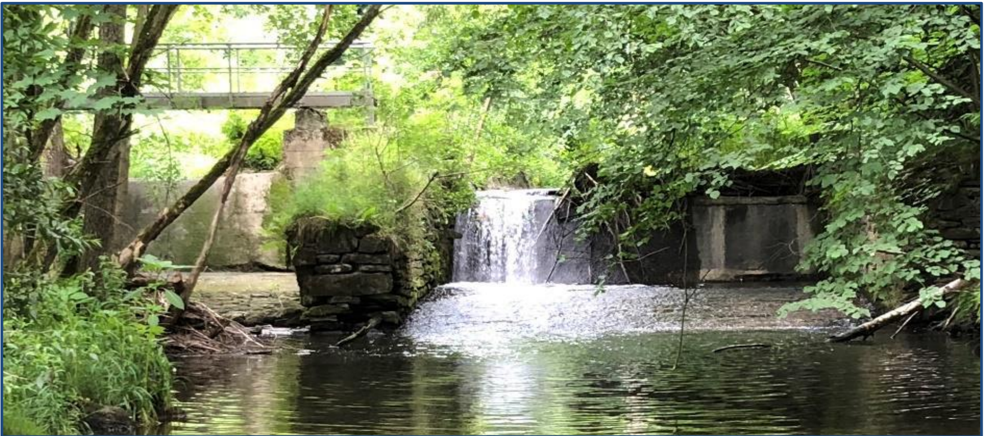
Gesamtansicht Wehr (Quelle: KUBENS Ingenieurgesellschaft mbH)
