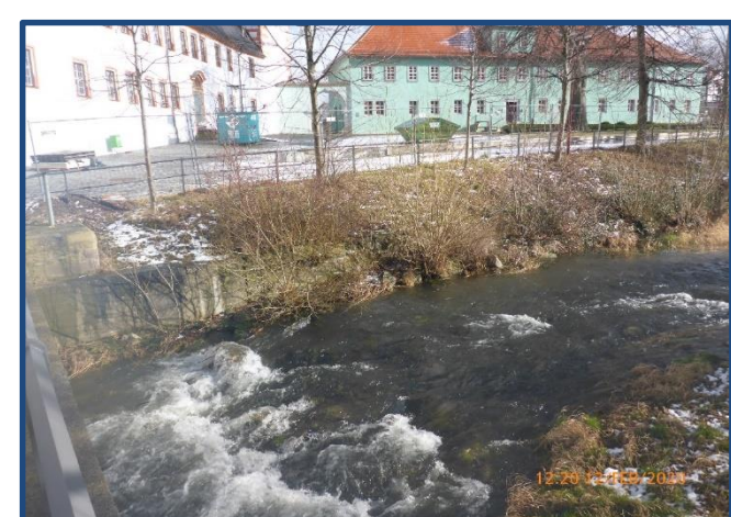
Abbildung OH 8, km 3,65, ehem. Wehr Schloss Ehrenstein, oberer Bereich der Sohlgleite (Quelle: ThLG)
