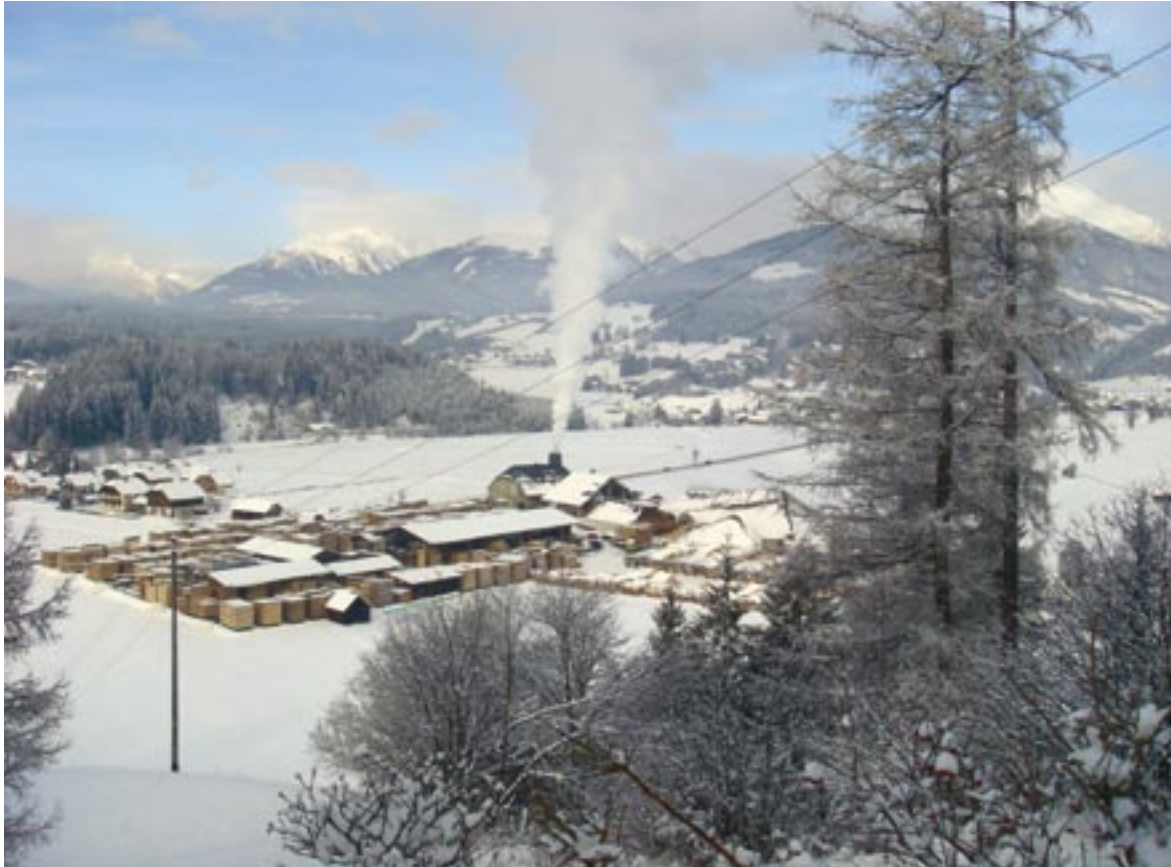
Biomasseheizwerk in Tamsweg (Österreich) (Foto: RAG Hildburghausen-Sonneberg)
