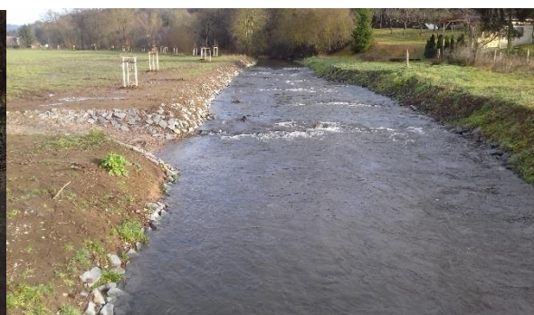
Fischtreppe in aufgelöster Riegelstruktur bei ehemals Wehr HA 17 (19.12.2019)
