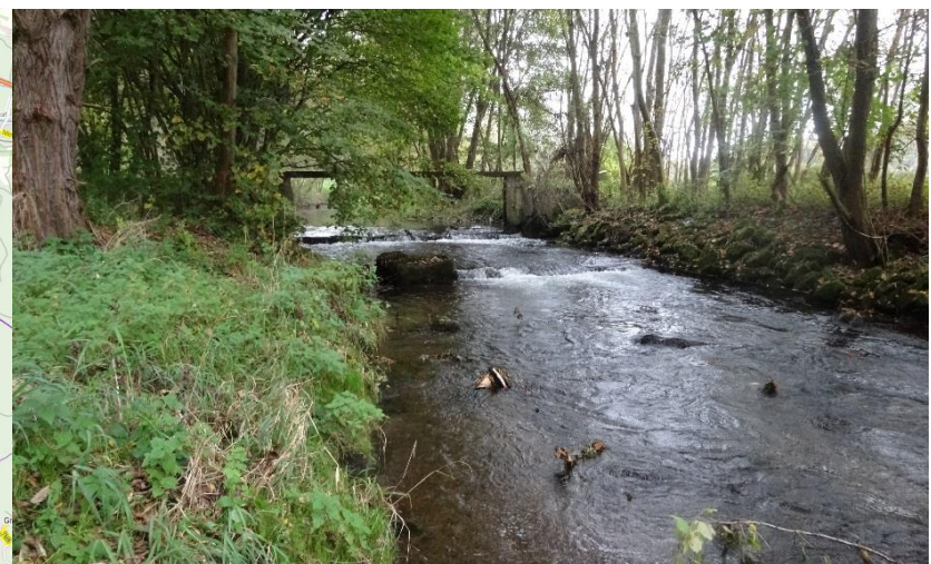
ehemaliges Wehr HA 16
