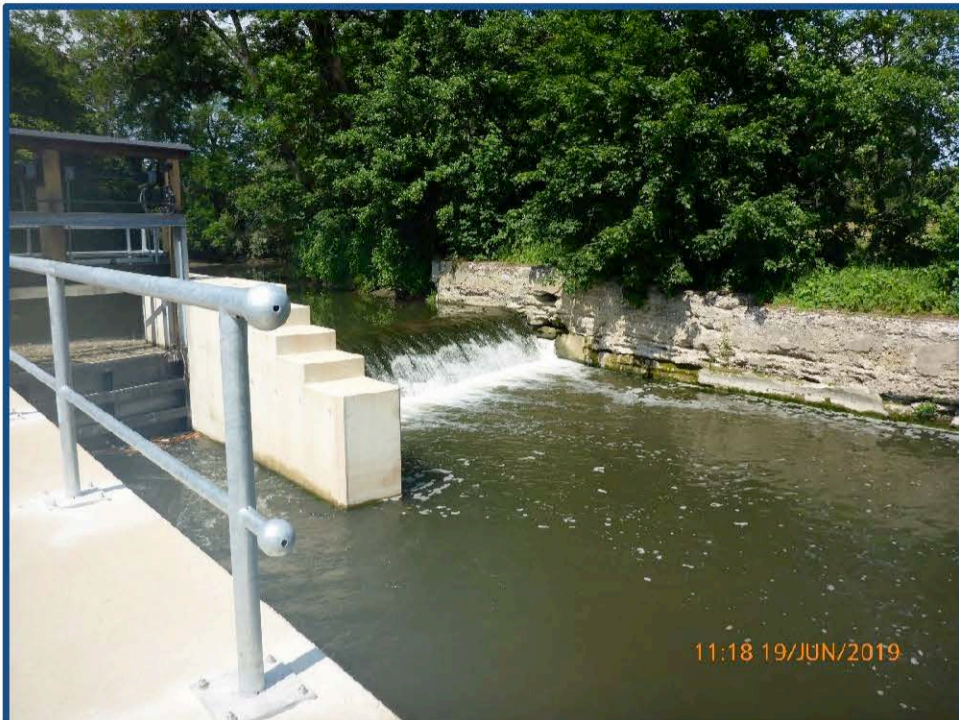
Wehrschwelle und Ufermauer Nordseite 19.6.2019 (Quelle: ThLG)
